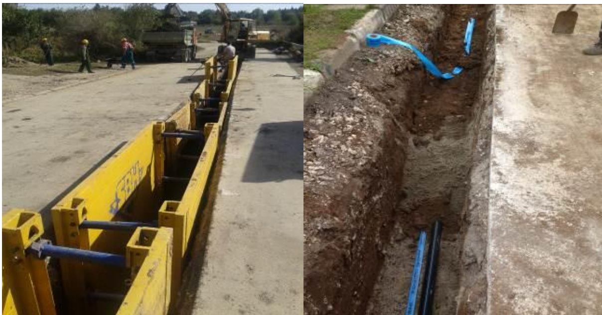
Снимки: Полагане на ВиК мрежа в община Кубрат (проект „Строителство и реконструкция на вътрешната водопроводна и канализационна мрежа на Кубрат и разширение на Пречиствателната станция за отпадъчни води“)
