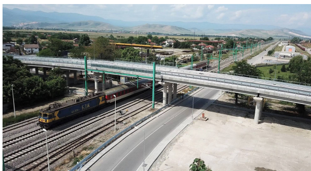
Пътен надлез в района на гр. Стамболийски
