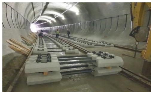
Полагане на метролинии
