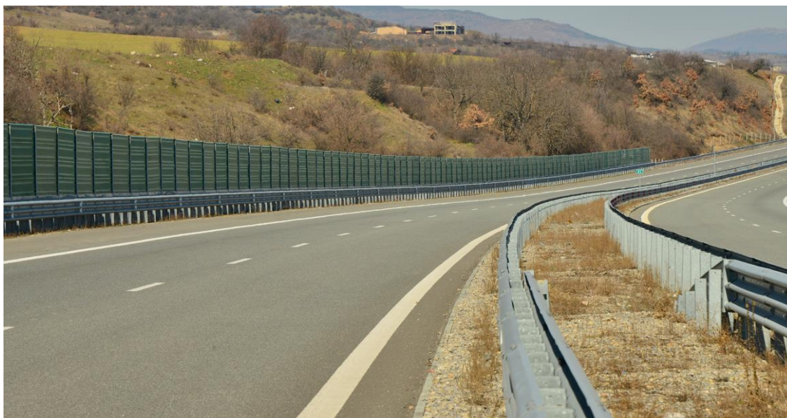
Снимков материал: Обход на Лот 3.1. Шумозащитни съоръжения
