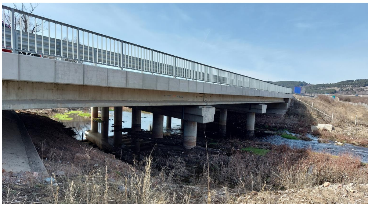
Снимков материал: Мостово съоръжение над р. Сливнишка
