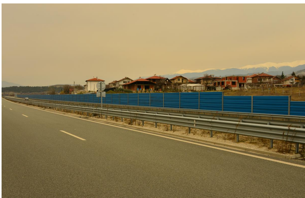
Снимков материал: Обход на Лот 3.3. Шумозащитни съоръжения
